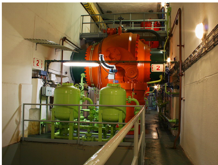
Pohľad na čerpadlo
